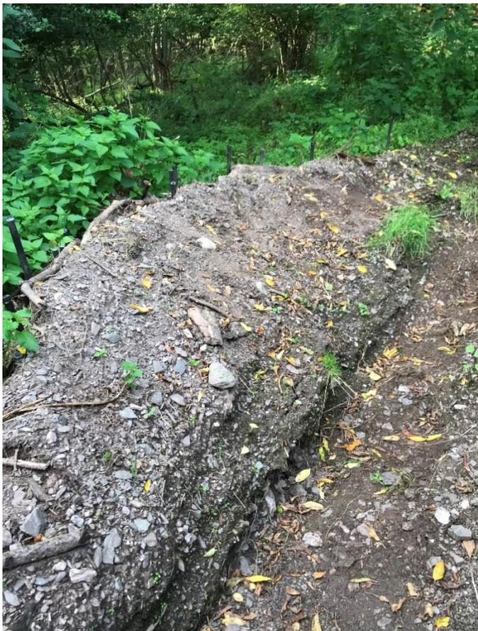
Abbildung 25: Erodierter Graben
